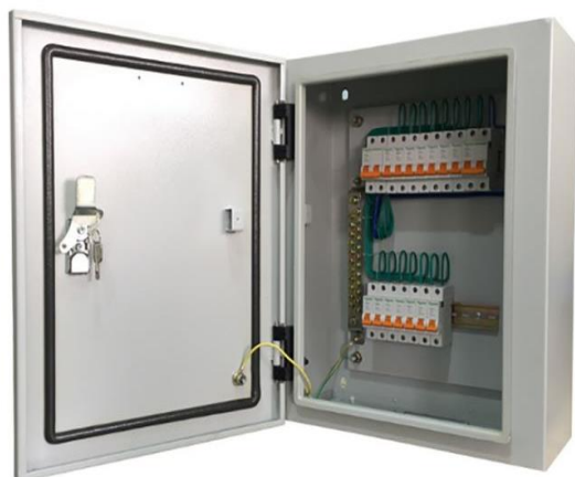
Rozvodná elektrická skriňa
